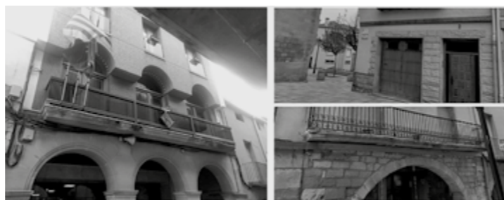
Fig.1. Cablejat sota la façana de l'Ajuntament. Exemples a ca la Sabatera i ca la Lissa d'una placa de fusta cobrint els cables reduint-ne l'impacte.
